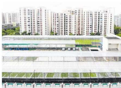
设在海军部道第354座多层停车场顶层的农场，去年初开始运作，公众每周六可到农场附近设置的农市购买新鲜蔬菜。（阮庆拍摄）
